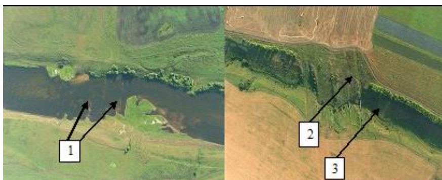
Рис.3. Прогноз аварийного состояния газопровода на участке перехода реки (левый снимок) и оврага (правый снимок): отчетливо дешифрируются русловые валы на участке всплытия газопровода (1); оползневой блок (2) висит на трубопроводах 1420 мм (3)
