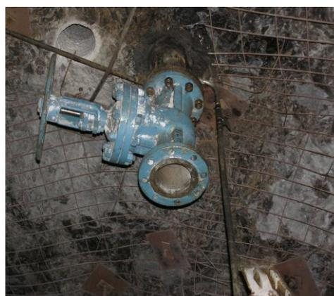
Рис. 4. Опрессовка устья скважины.
