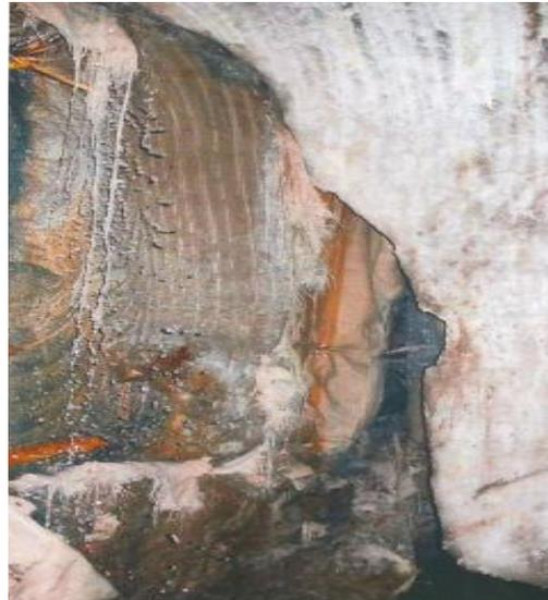
Рис. 1. Капеей рассолов в промоине первого блока.
