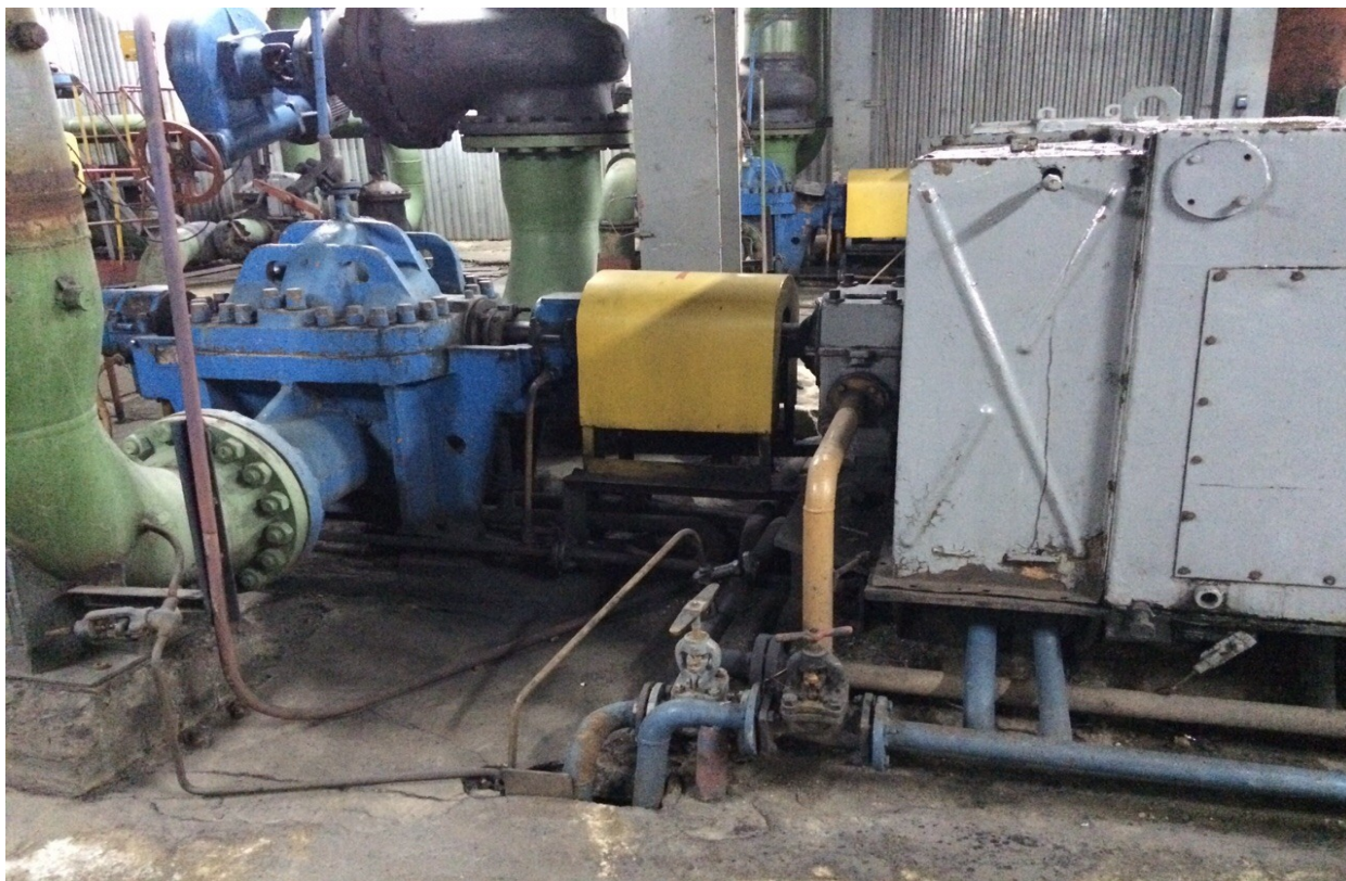
Рисунок 2.3 - Конденсатный насос
