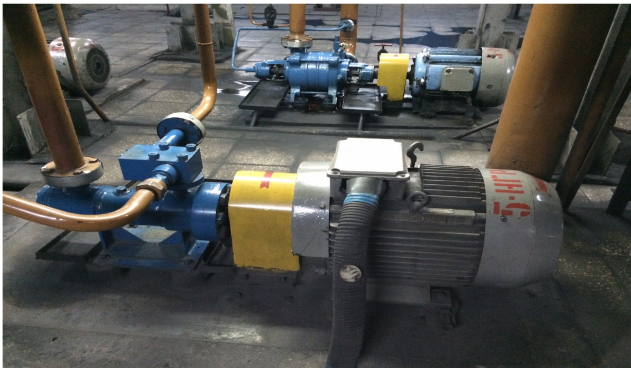
Рисунок 2.2 - Насос гидравлического подъема роторов
