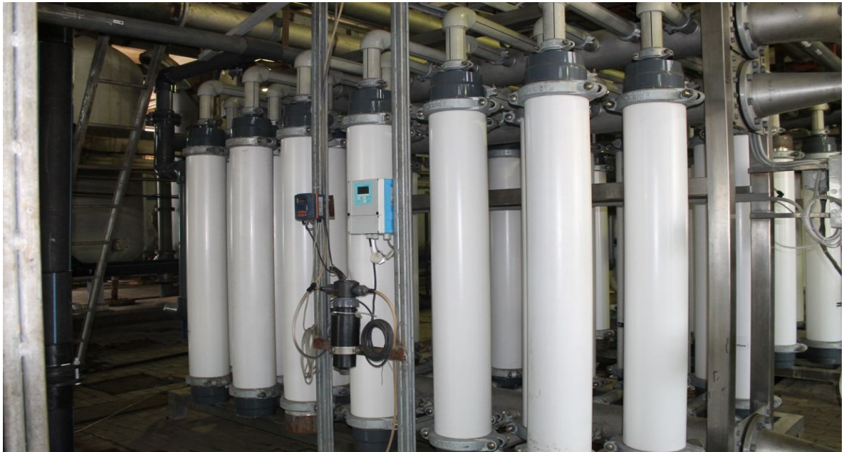
Рисунок 19 - Установка ультрафильтрации
