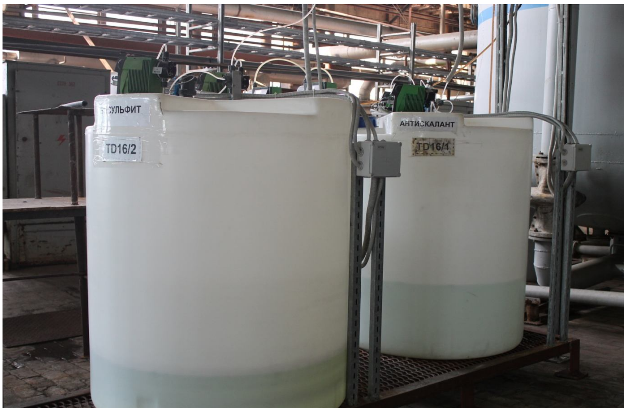
Рисунок 22 - Узел по вводу антискаланта и биоцида
