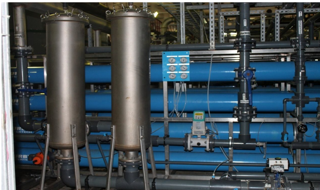
Рисунок 15 - Установка обратного осмоса Фильтр АФ-1ступени (10) показан на рисунке 16.
