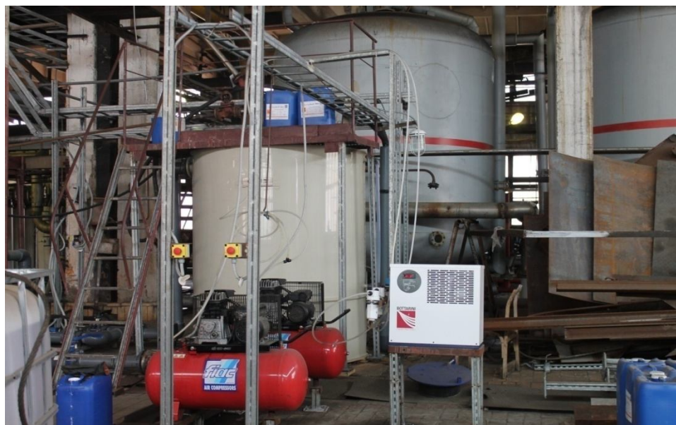
Рисунок 17 - Узел дозирования коагулянта и гипохлорита
