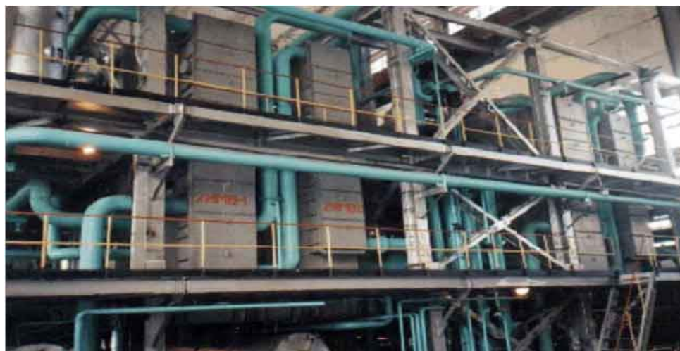
Рисунок 39- Испарители ИМВ-50 в составе термообессоливающего комплекса 320 т/ч Казанской ТЭЦ-3
