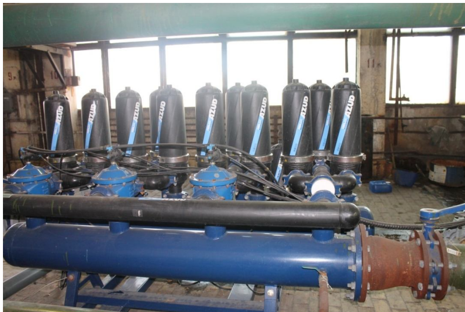
Рисунок 13 - Самопромывные механические фильтры MF-02 (4)
