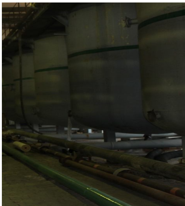
Рисунок 12 - Механические фильтры МФ-1-5
