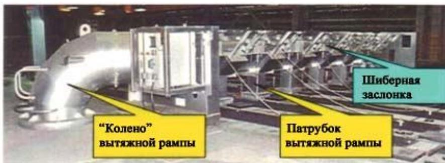
Рисунок 10 - Вытяжная ramпа, соединяющая отдельные газоходы с обводным газоходом. На каждой ветви – шиберная заслонка для регулирования тяги
