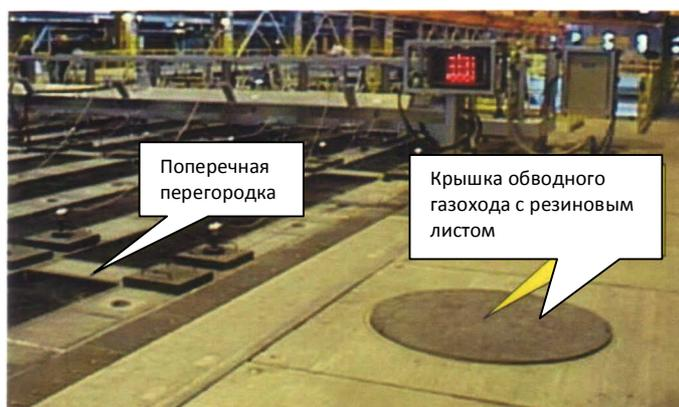
Рисунок 8 - Крышка обводного газохода с резиновым листом на неиспользуемом стояке обводного газохода
