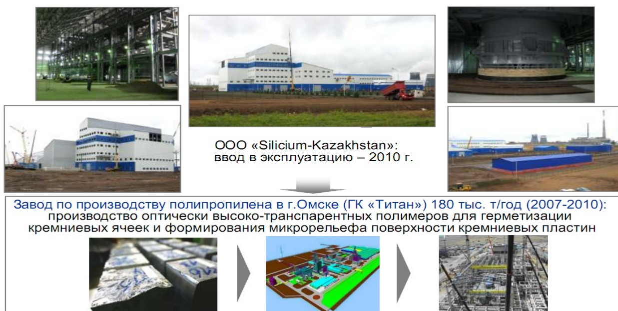
Рисунок 14 – Завершение строительства завода по производству металлургического кремния в Казахстане [18]
